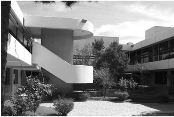
Edificio interior del IICO.
