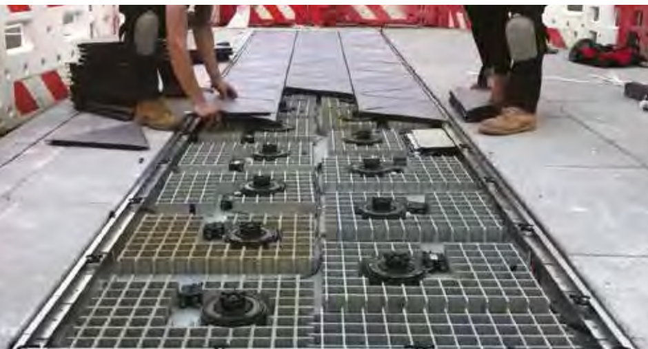
Piezolectricidad. Colocación de cristales piezoeléctricos en una calle para generar energía eléctrica sostenible.
